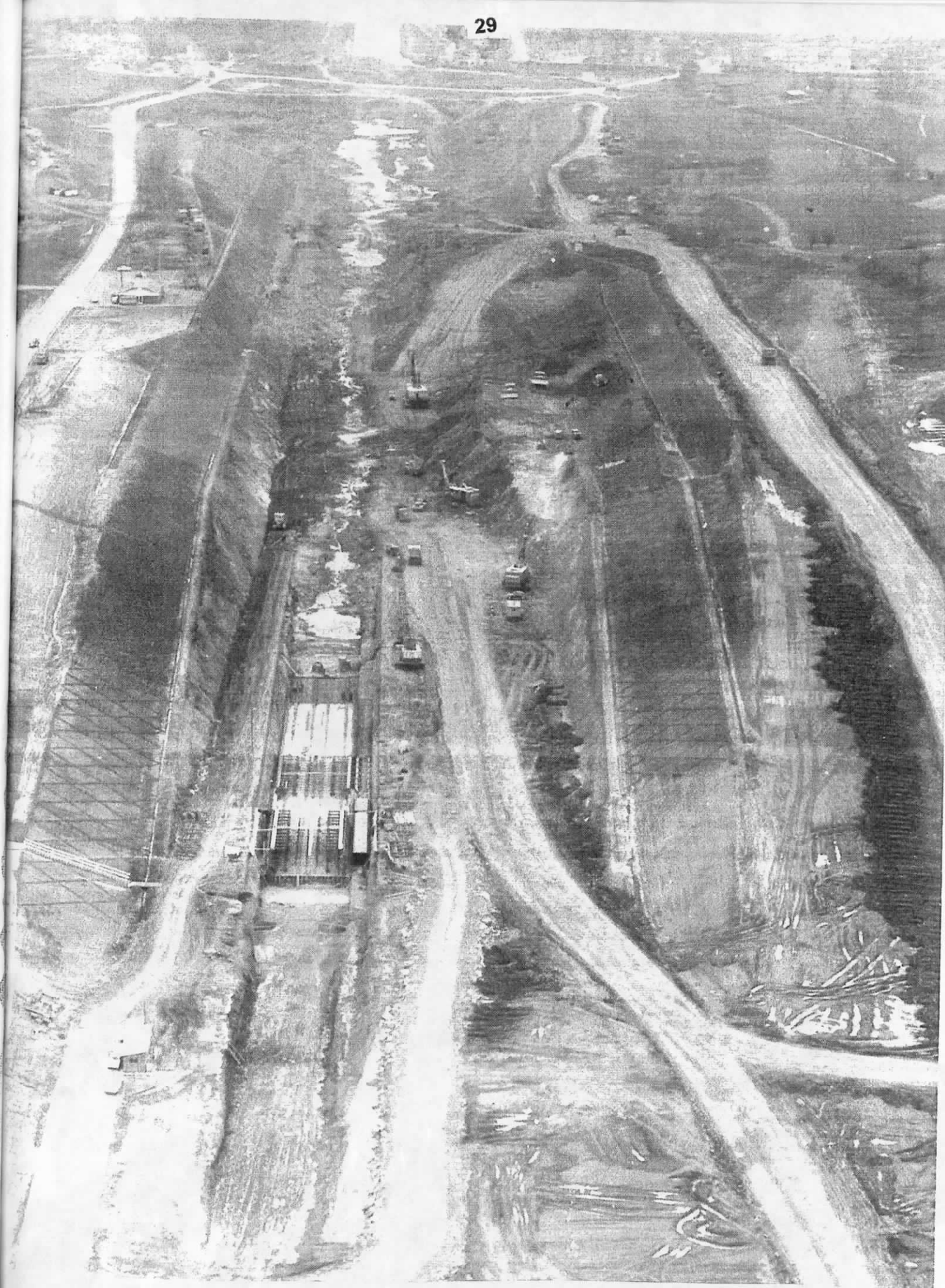
Du haut de la tour, vue de la grande tranchée, avec le début du bétonnage du premier chemin de roulement des bacs ...
