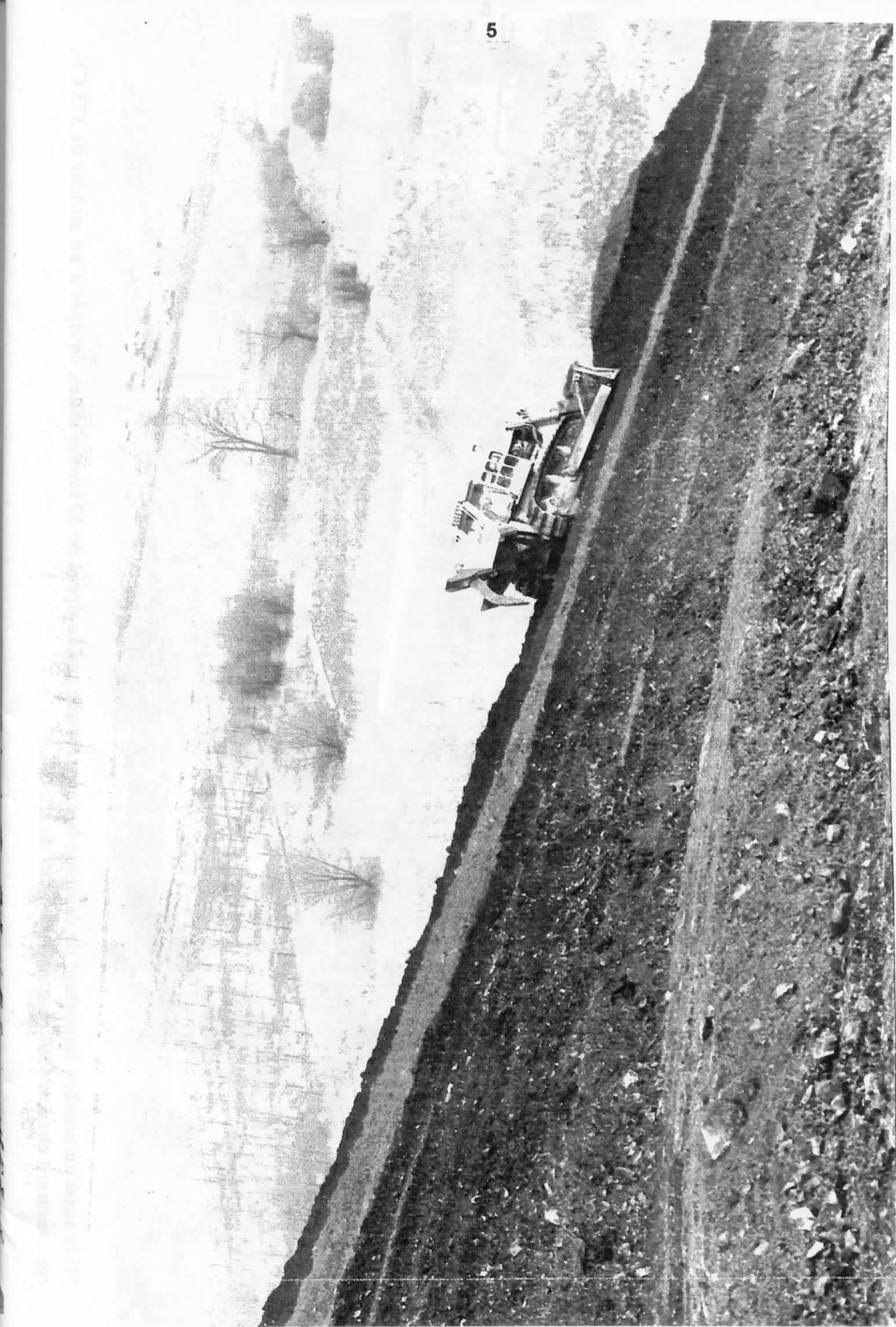
... consommant 15 000 litres de gasoil en une journée de 9 heures mais excavant, transportant et mettant en remblais 20 000 m 3 de terre
